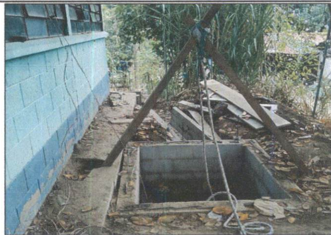
Foto 4: Mejoramiento de cunetas y alcantarillado respectivo.
