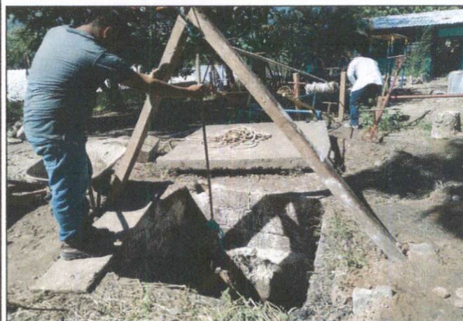
Foto 2: Limpieza de la fosa séptica a mejorar.
